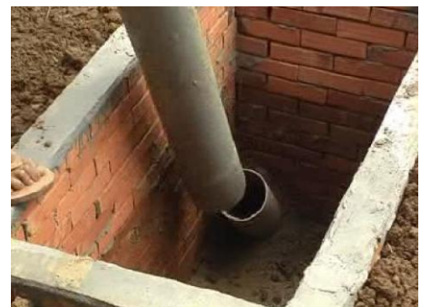
Hình 3: Bể chứa bã cặn
