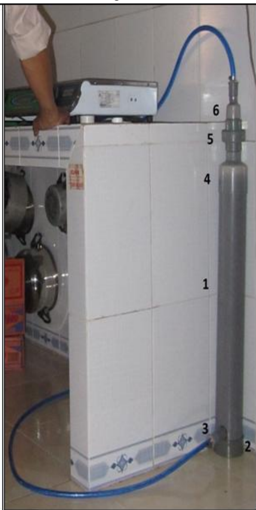
Hình ảnh bộ lọc khí sinh học sau khi lắp đặt hoàn chỉnh
