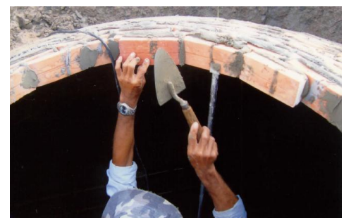
Hình 5: Xây thành vòm
